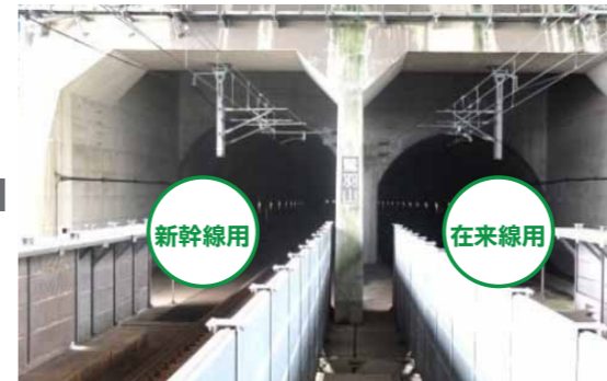
鷲羽山トンネル
